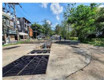
ระบบบำบัดน้ำเสียแบบตะกอนเร่งกวนสมบูรณ์ ติดตั้งได้พื้นคอนกรีต
